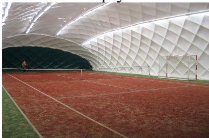
přetlaková nafukovací hala
